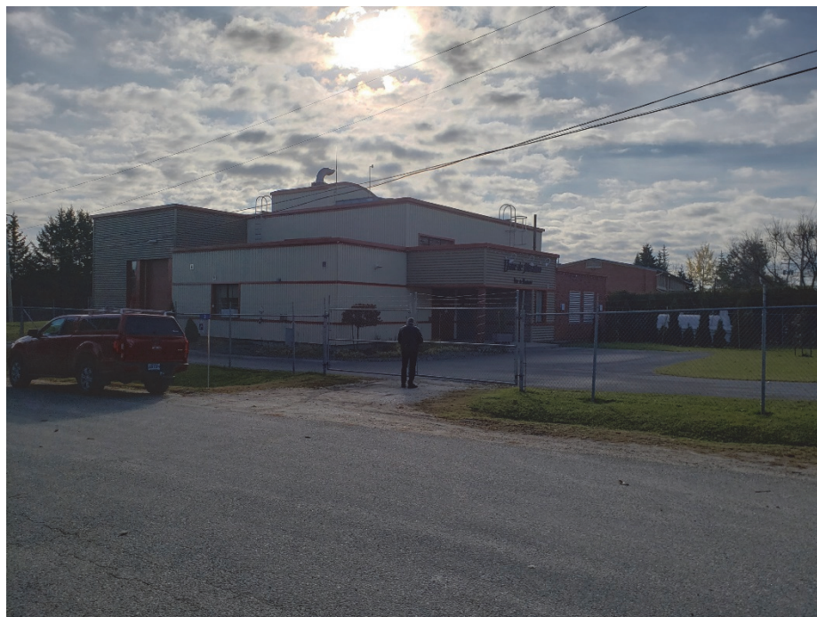
Photo 1 : Aperçu du bâtiment de production d'eau potable – 2020-10-22
